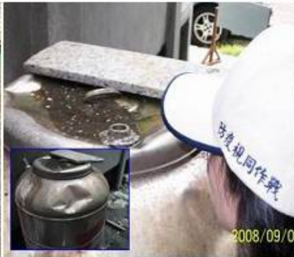
儲水桶鐵蓋凹陷處
