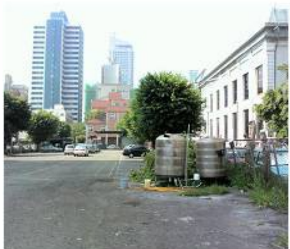
停車廠水塔無蓋
