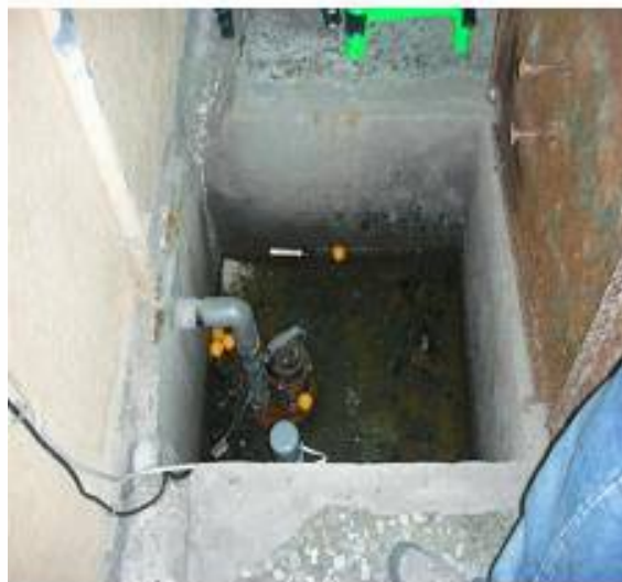
地下室集水槽
