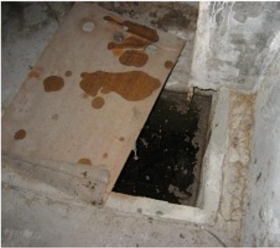
地下室污水池
